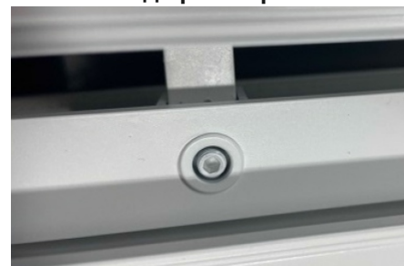
Узел регулировки подвижного дефлектора
